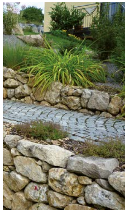
Trockenmauerbau Foto © Michael Grill
